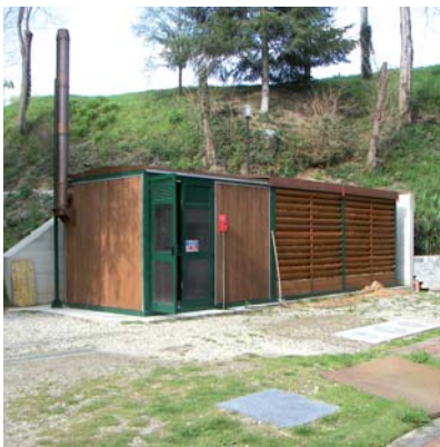
Modulo mobile (plug&play), con caldaia a cippato fino a 150 kW, particolarmente idoneo al contracting agroforestale
